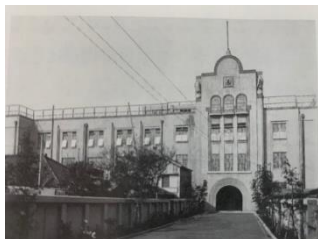
昭和2年 鉄筋コンクリート3階建て
